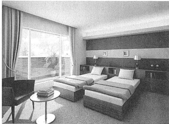
壁と天井のクロスの上にウェルネスエアを設置した部屋
